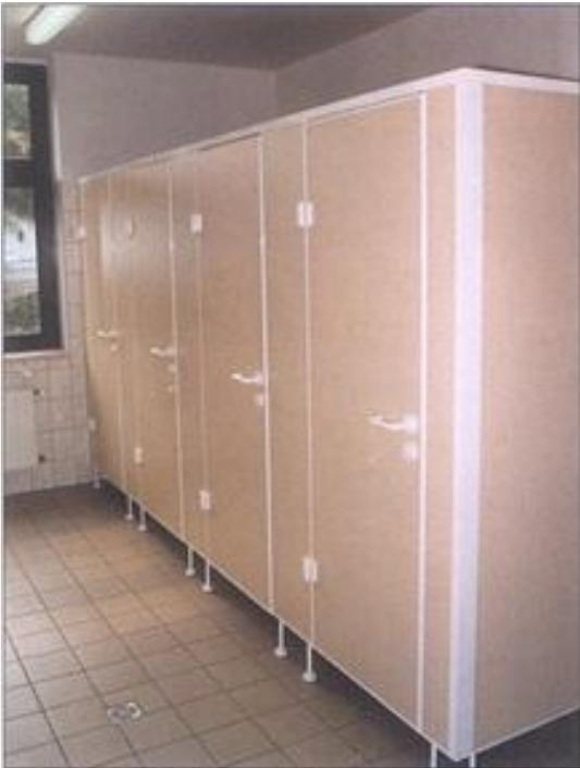
**Wände:** 30 mm stark, beidseitig Melaminharz beschichtete Spanplatte, Wandanschluss besteht aus spez. Alu-Profil, Kantenabschluss ebenfalls durch spez. Alu-Profile, Anlage steht auf höhenverstellbaren LM-Stützen, dadurch bequemer Ausgleich von Bautoleranzen. Abwinkelungen beliebiger Gradzahl sind in Vorderfront und Zwischenwänden möglich.
